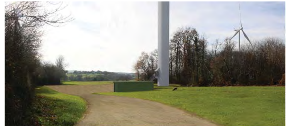
Figure 185 : Simulation du poste 2 au pied de l'éolienne E5
