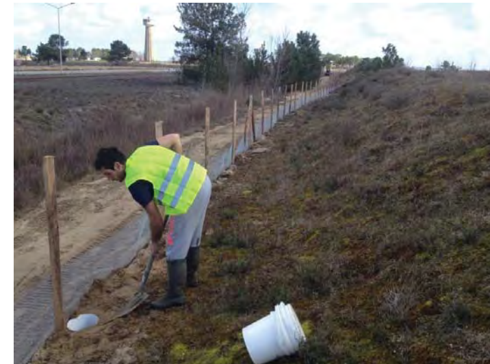
Photo 66 : Exemple d'une barrière à amphibiens (source : Simethis)
