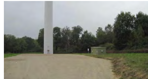
Photo 70 : Poste de livraison existant au pied de l'éolienne 1 du parc de Saulgond-Lesterps
