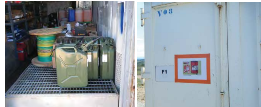
Photo 44 : Exemple de local fermé contenant des produits sur système de rétention (©Corieaulys)
