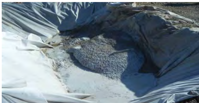
Photo 49 : Mesure de prévention de pollution par le béton (protection par géotextile pour le nettoyage des goulottes des camions toupie) - © Corieaulys
